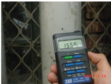
實驗室外牆高壓電纜 1558mG
