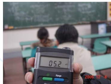
天花板高壓電纜 教室內 5.2mG
